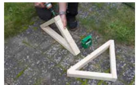
**18.** Für die Maltischkonsolen zwei 500 mm lange Rahmenhölzer im rechten Winkel zusammenschrauben. Die Enden der Verbindungsstrebe mit einem Winkelschnitt von 45° versehen und anschrauben.
