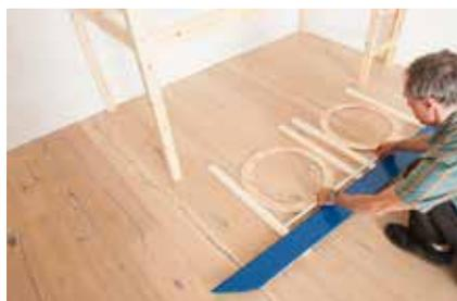
**8.** Die Beplankung wird von hinten zusätzlich mit vier Rahmenhölzern (Länge 700 mm) versteift. Die Anordnung von Rahmenhölzern und Bullaugenrahmen vor dem Bett am Boden ausmitteln.
