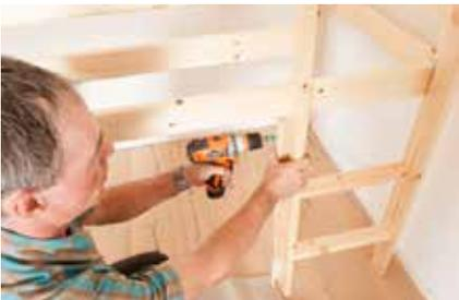
**13.** Für die Montage der Beplankung an der Leiterseite ein auf Länge geschnittenes Rahmenholz anschrauben.
