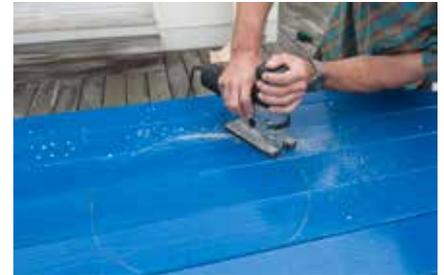
**12.** Die Öffnungen mit der Stichsäge ausschneiden. Tipp: Je schmäler das Stichsägeblatt, desto besser lassen sich Rundungen sägen.
