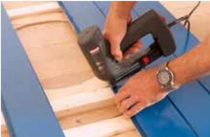
**10.** Mit leichtem Druck werden jetzt alle Profilbretter in die Nut- und Feder-Verbindung geschoben und jeweils in den Federn angetackert.
