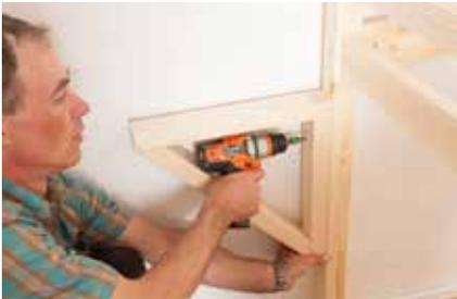
**19.** Die Konsolenträger und die Tischplatte ölen. Dann die Träger an die Bettpfosten befestigen. Die Tischplatte von unten mit Schrauben auf den Konsolen befestigen.
