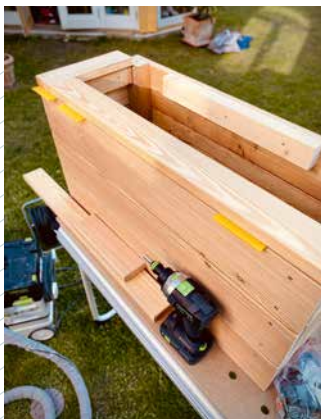
Die Abdeckung zuschneiden und verleimen. Um den Kasten mit Erde zu befüllen, sollte die Abdeckung abnehmbar bleiben.
